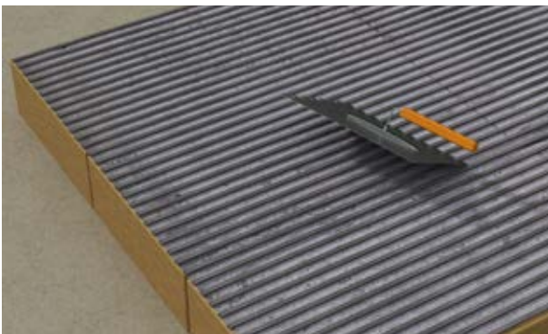
Rozprowadzanie zaprawy packą zębatą
