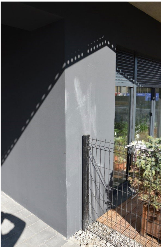
Przetarcia powstałe przy usuwaniu zabrudzeń
