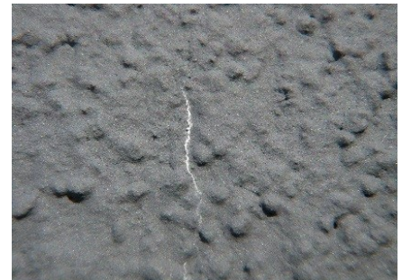
W miejscach występowania rys termicznych mogą pojawić się wykwitły wapienne.
