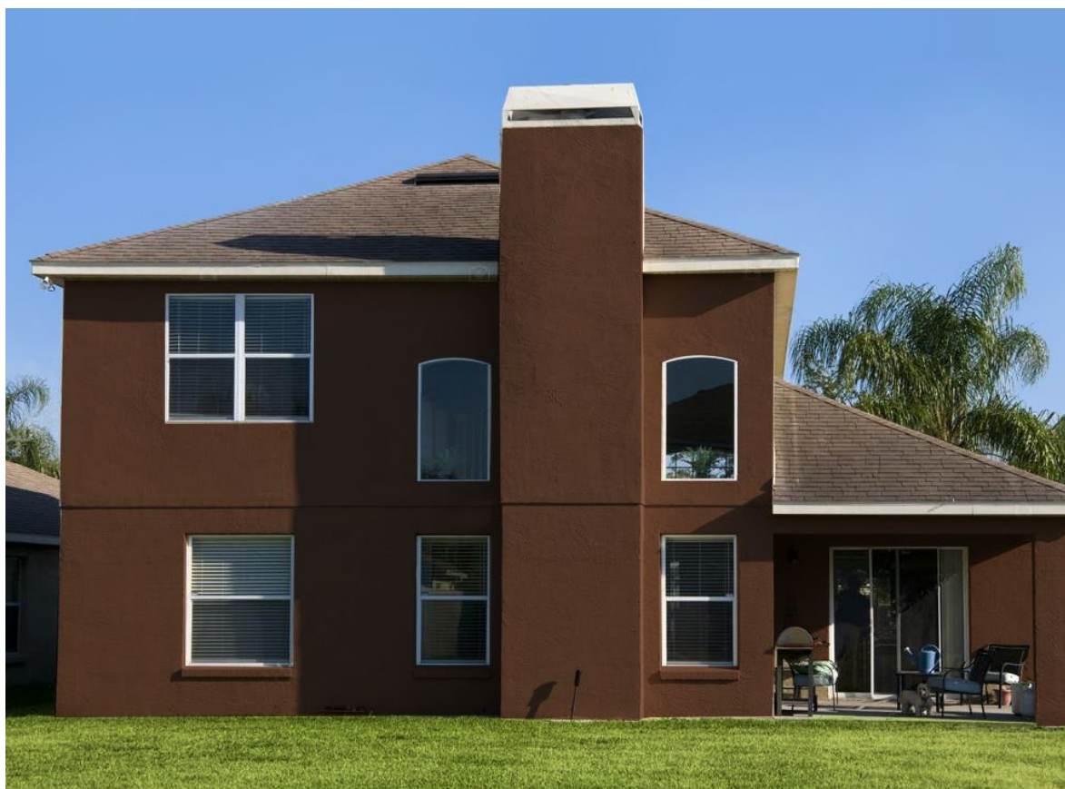
Przykład elewacji wykonanej w ciemnych kolorach
