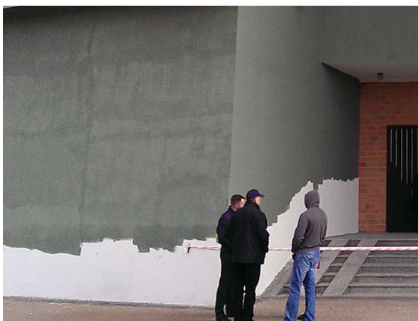
Porównanie efektów malowania farbą ThermoSan rozcieńczoną wodą (po lewej) oraz Amphisilan Tiefgrund LF (po prawej).
