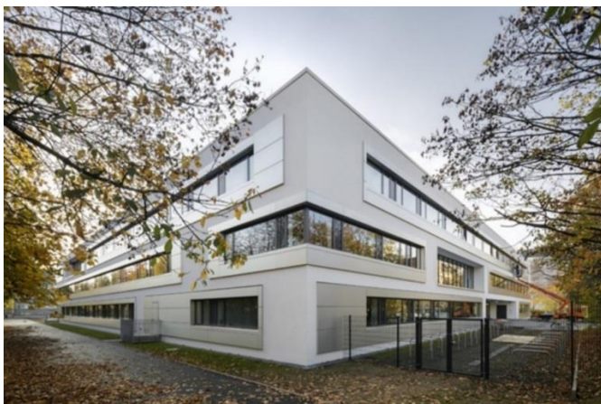
Szkoła podstawowa w Lipsku, 4000m 2 ocieplenia ETICS, 2014r. (Capatect ZF-Spachtel 699, ocieplenie Dalmatiner Fassadendaemnpfplatten 160 WLZ, tynk i farba Amphisilan NQG)
