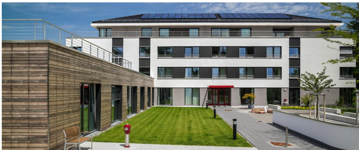
Prywatna klinika SysTelios w Odenwald, 2500m 2 pow. Ocieplenia ETICS, 2011r. (Capatect Dalmatiner Fassadendaemplatte 160 WLZ, siatka Capatect 650/110, masa klejowo-szpachlowa 186M, tynk i farba Amphisilan NQG)
