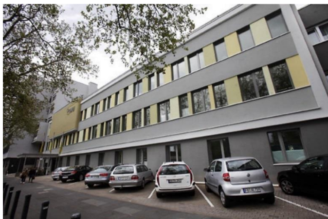
Biurowiec Instytutu IWU w Darmstadt, Zapotrzebowanie na ciepło ogrzewania O_n \leq 16 \text{ kWh}/\text{m}^2\text{a} , 2011r. (Capatect-PS-Dalmatiner-Fassadendämmplatten 155 EPS 032, tynk i farba Thermosan, farba Metalloacryl Exterior)
