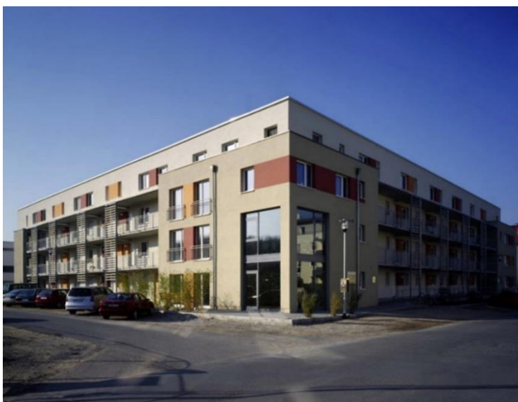
Inwestycja WohnArt 3 w Darmstadt, ocieplenie ETICS, 2010r. (Capatect Dalmatiner Fassadendaemplatte 160 WLZ 034, tynk Mineral-Leichtputz, farba Thermosan NQG)
